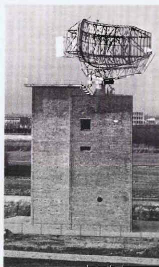
Fig. 18. Het antenne systeem van de lange afstandradar op Schiphol
